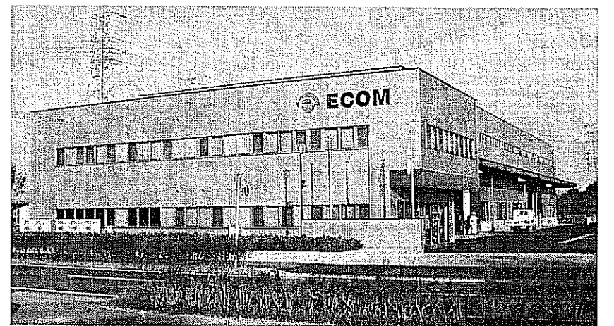
中小企業の設備投資も活発(写真:エコム新工場)
