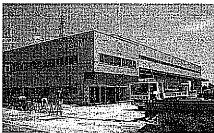
建設中のエコム新工場(浜松市)
