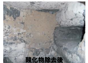
酸化物除去後 (熱間・冷間ハツリ実施)
