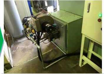
施工後 (ガスバーナ)
