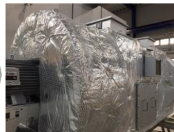
▲炉全体を断熱材で覆った状態。見た目にもきれいに蘇ります
