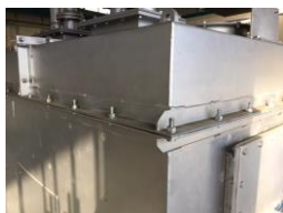
▲耐熱のシルバー塗料のみが塗られた状態(施工前)
