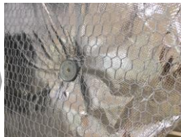
▲厚さ25mmの断熱材(ロックウール)をピンとネットを使って固定します
